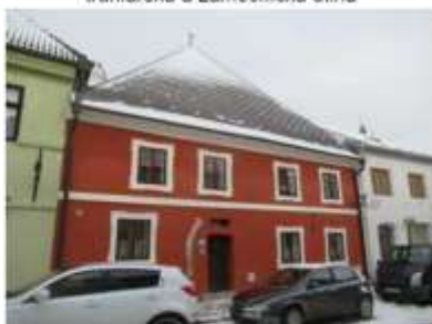
Dům č.p. 83 v Pelhřimově
