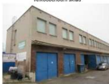
garáže s ubytovnou
